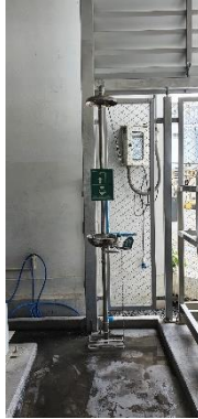
รูปที่ 27 ฝักบัวฉุกเฉินและอ่างล้างตา
